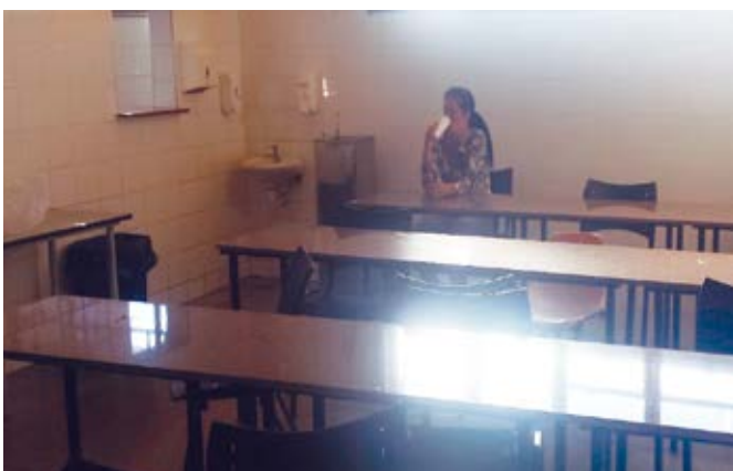
Refeitório era pequeno, escuro e sem climatização
