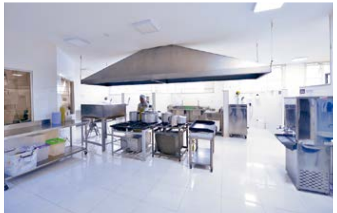
Espaço recebeu nova estrutura elétrica e hidráulica, além da substituição de piso, móveis e utensílios
